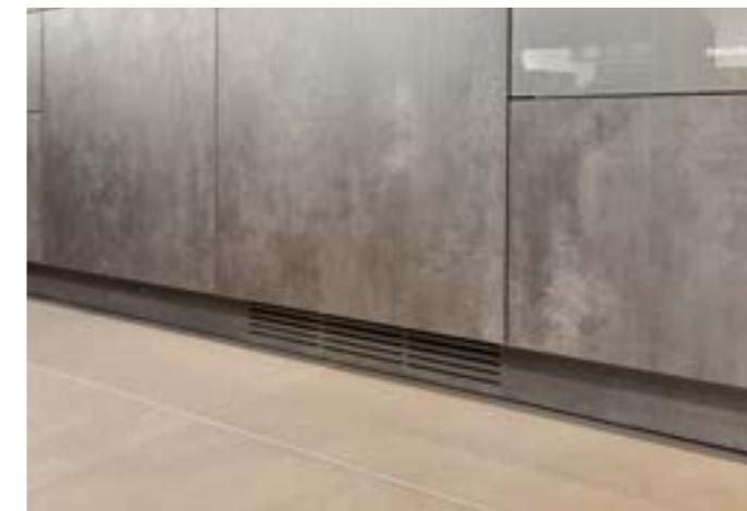
Eine Besonderheit der E-Line sind die Sockel aus extra wasserfestem Holzwerkstoff, die mit beidseitigem Kunstharzbelag den perfekten Abschluss zum Boden bilden. Auf Wunsch können die Lüftungsschlitz für Kühl- und Gefrierschrank direkt eingearbeitet werden.
